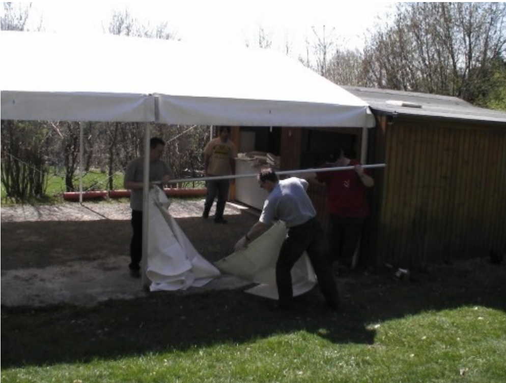
? Die Seitenwände werden angebracht. So langsam wird aus dem Stahlgerüst ein Zelt
